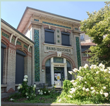
Les anciens Bains-Douches accueillent la nouvelle crèche ovilloise
